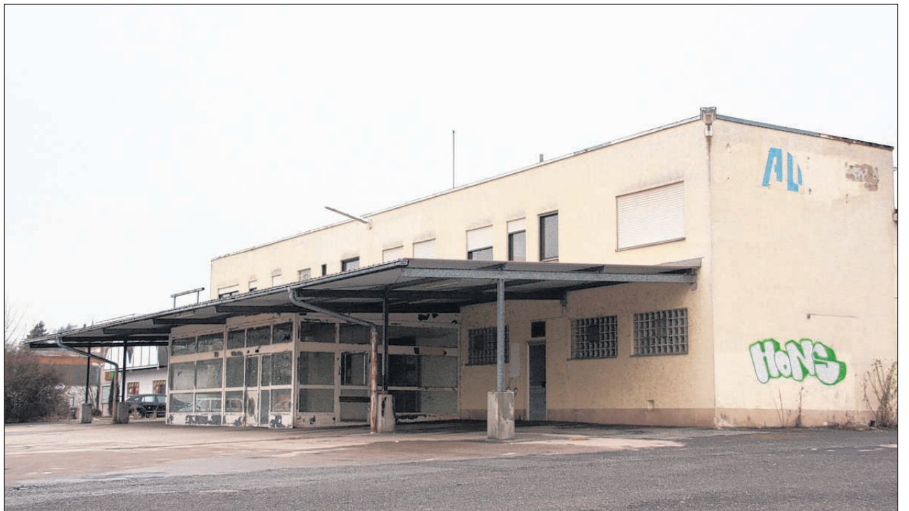
Sieht noch nicht nach Forschungscampus aus: Der ehemalige Algro-Markt in der Badstraße in Cham wird umgebaut. Hier soll die Außenstelle der FH Deggendorf einziehen.
