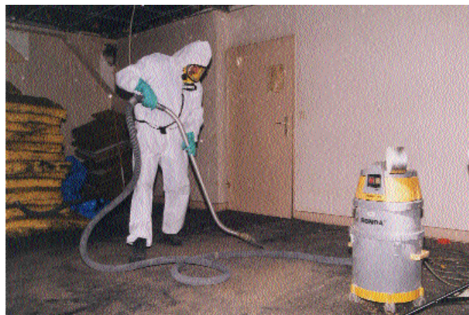
Abb. 14: Reinigungstätigkeiten mit einem K1-Industriestaubsauger in einem mit Taubenkot verschmutztem Gebäude in Berlin. Tauben hatten seit etwa 1993/94 keinen Zugang mehr zu den Räumlichkeiten
