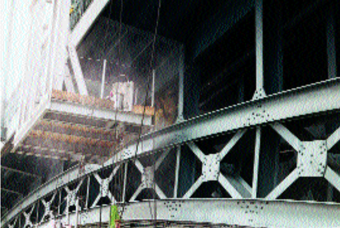
Abb. 8: Reinigungstätigkeiten an einer Brücke zwischen Mainz und Wiesbaden. Die Taubenkotverunreinigungen wurden mit Hilfe von Hochdruckreinigern (100 bar Druck, 95° C) entfernt. Deutlich sichtbar ist die dabei entstandene Aerosolwolke. Im linken Bildteil ist eine begehbare Arbeitsplattform zu sehen
