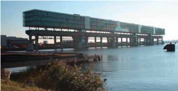
Abbildung 31: Die revitalisierte “Grüne Immobilie des Jahres 2008” ist ein Bürokomplex in Amsterdam, der auf einer ehemaligen Kranspur aufgebaut wurde und Flusswasser zum Heizen und Kühlen verwendet. Quelle: [Commerz Real]
